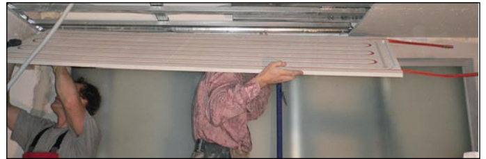
Stropni element Variotherm
