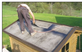
Izvedba obrob in hidroizolacije
